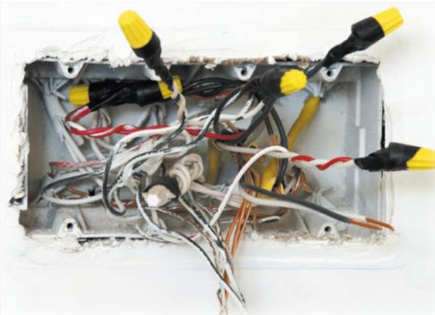
Распределительная коробка со снятой крышкой
